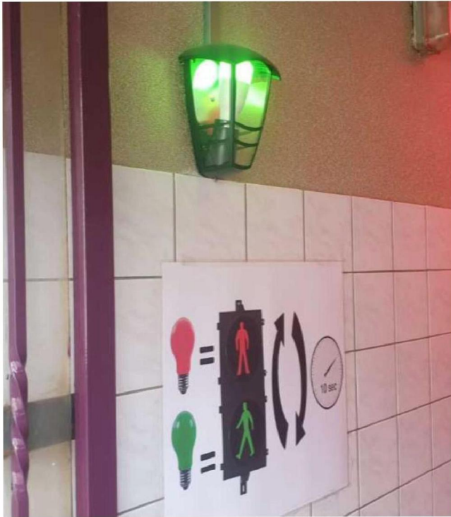
Sluissysteem smallere doorgangen
